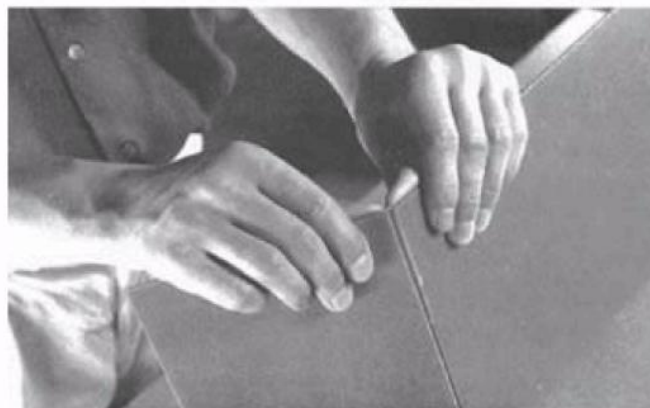
Рисунок 11 - Нанесение бороздки и поломка
